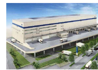
QP Log. / Tokorozawa
